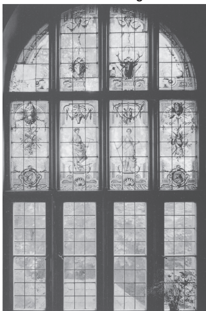
Fenster im Treppenhaus von Gut Ringelsbruch, Zustand 1979
